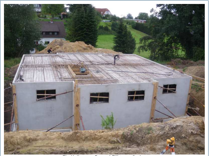
Ein Keller aus Doppel-Filligranwänden
