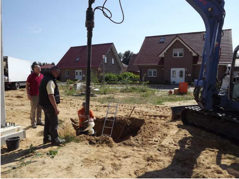
Ein kleiner Bagger mit Bohraufsatz sorgt für Energie
