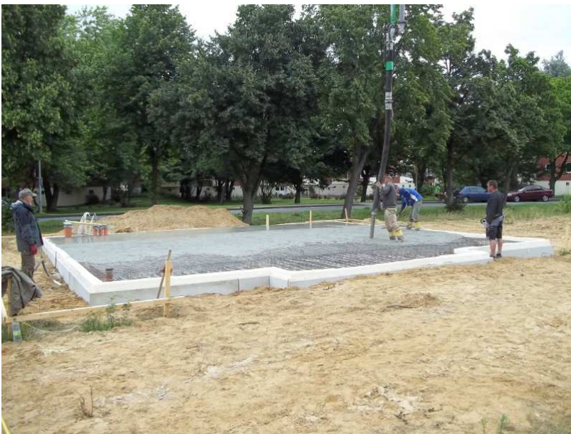
Beton fließt in die bewehrte Sohlplatte
