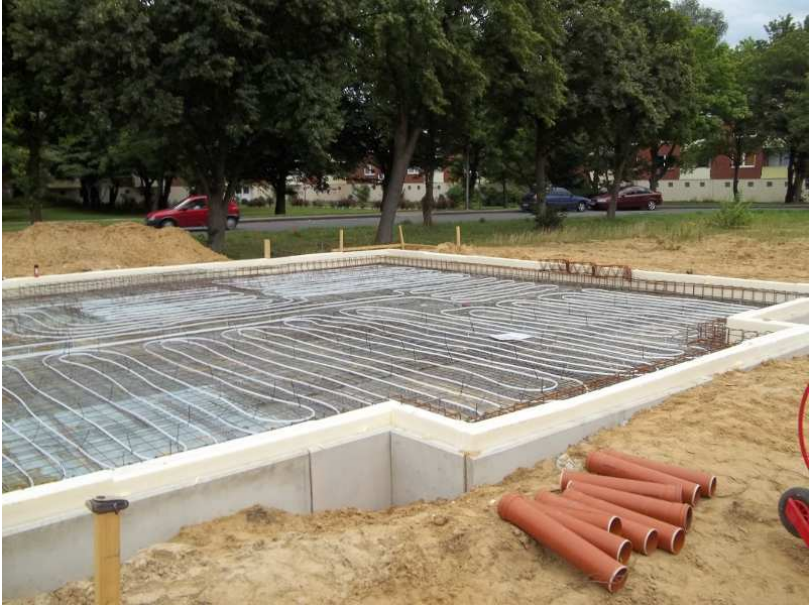
Sohlplatten sind bereits temperiert und ringsum gedämmt
