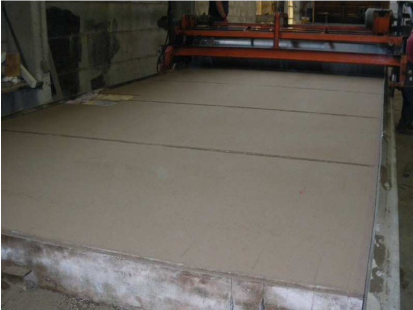
Der Beton wird in der Schalung gewalzt
