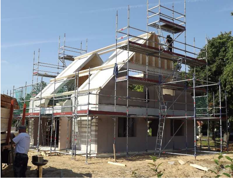
Die Dachdeckerarbeiten können beginnen
