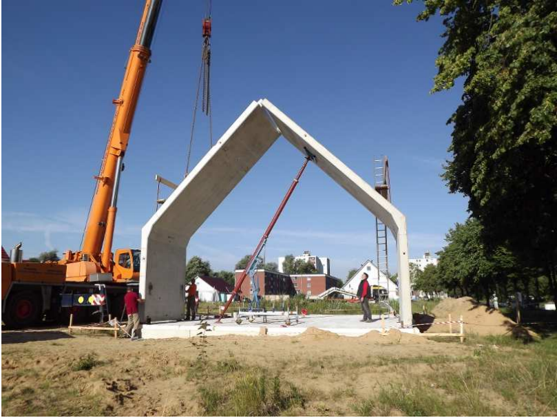
Das zweite Hauselement wird gegen das erste Element gelegt
