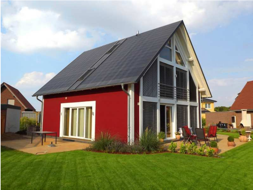
Große Fensterflächen sorgen für einen hohen Sonnenertrag
