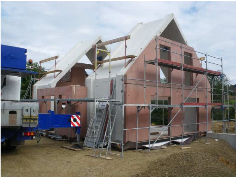
Der Rohbau steht
