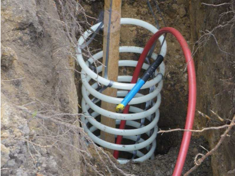
Eine Helixsonde im Erdboden
