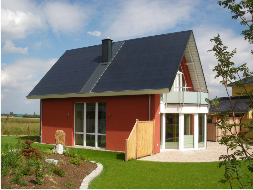
Dachbildende Dünnschichtphotovoltaik ist eine Alternative
