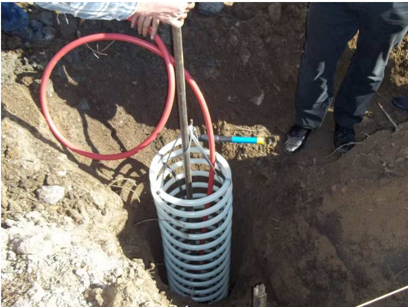
Die Helixsonden lassen sich in Minutenschnelle in den Boden einbringen
