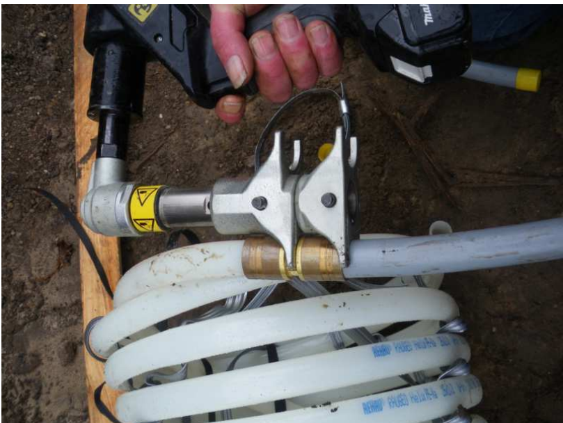
Die Rohre werden untrennbar miteinander verquetscht
