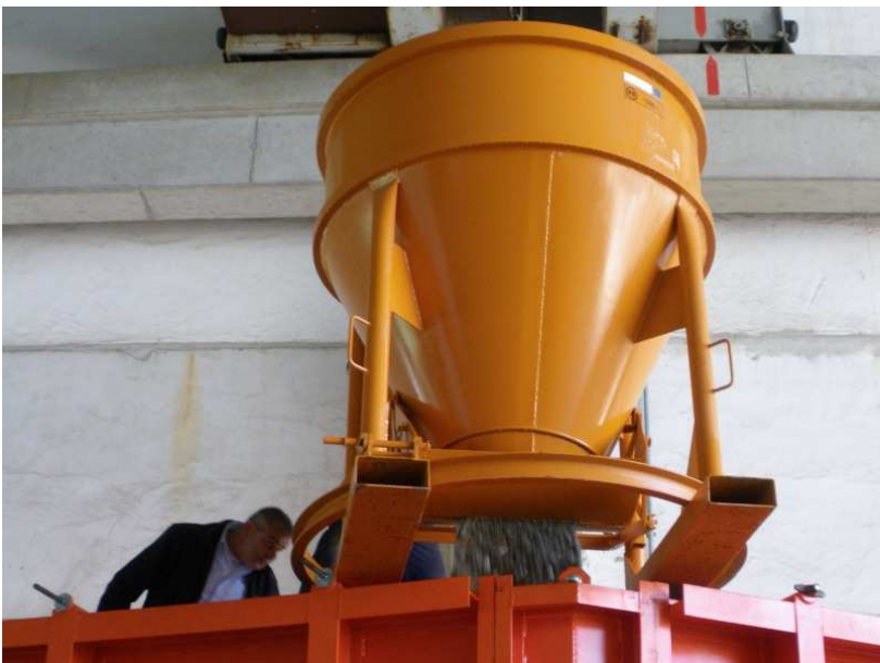
Betonieren eines stone-Lofts
