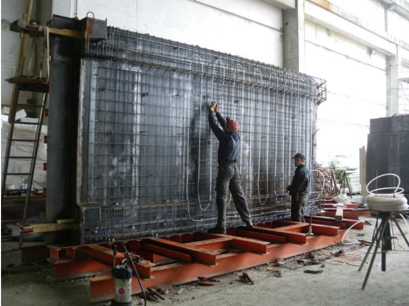
Verlegung der Temperierungsleitungen im Werk
