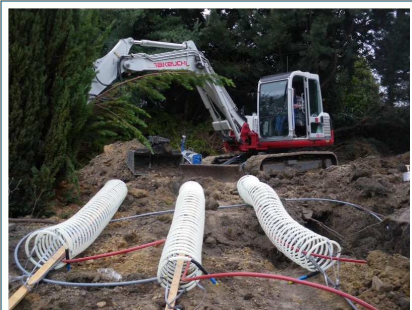
Das Einbringen von Helixsonden ist einfach und günstig
