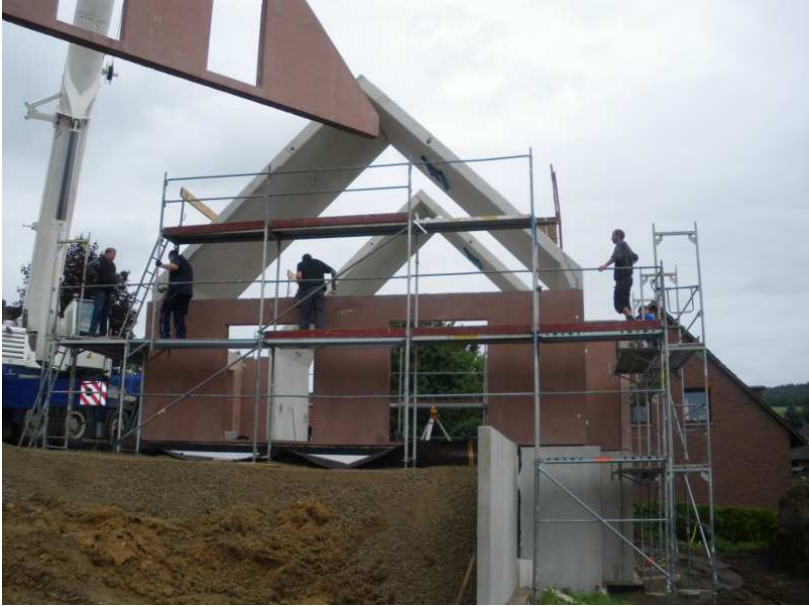
Ein Giebelelement wird montiert
